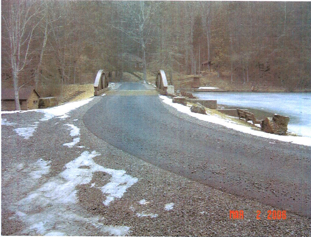
SENECA DAM MODIFICATION, POCAHONTAS CO., WV
