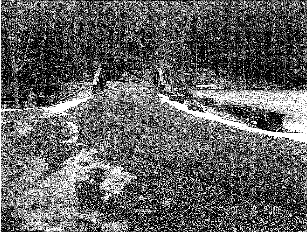
SENECA DAM MODIFICATION, POCAHONTAS CO., WV
