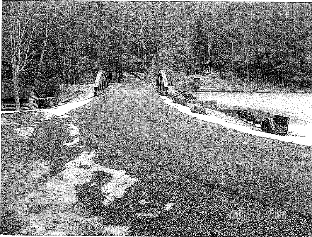
SENECA DAM MODIFICATION, POCAHONTAS CO., WV
