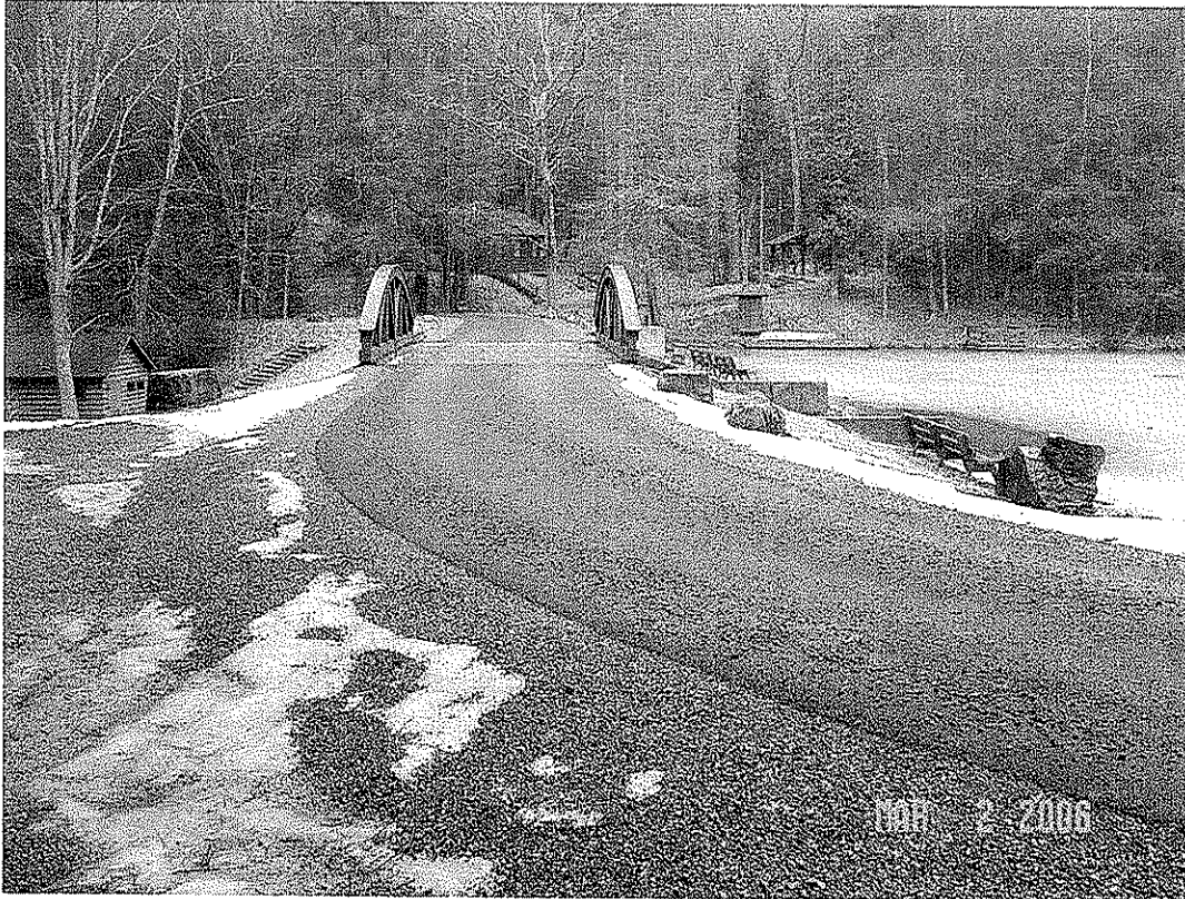
SENECA DAM MODIFICATION, POCAHONTAS CO., WV
