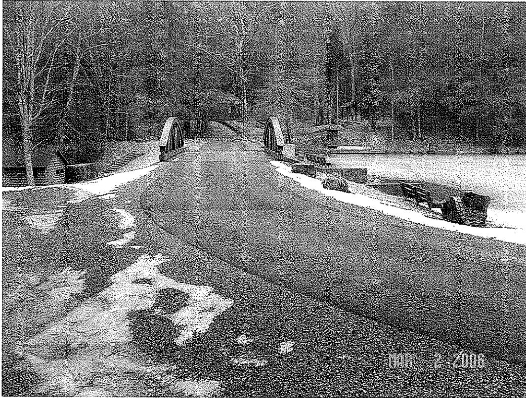
SENECA DAM MODIFICATION, POCAHONTAS CO., WV
