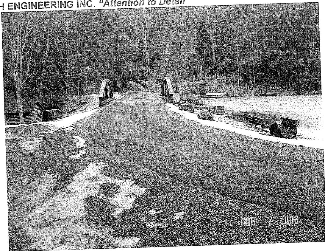
SENECA DAM MODIFICATION, POCAHONTAS CO., WV
