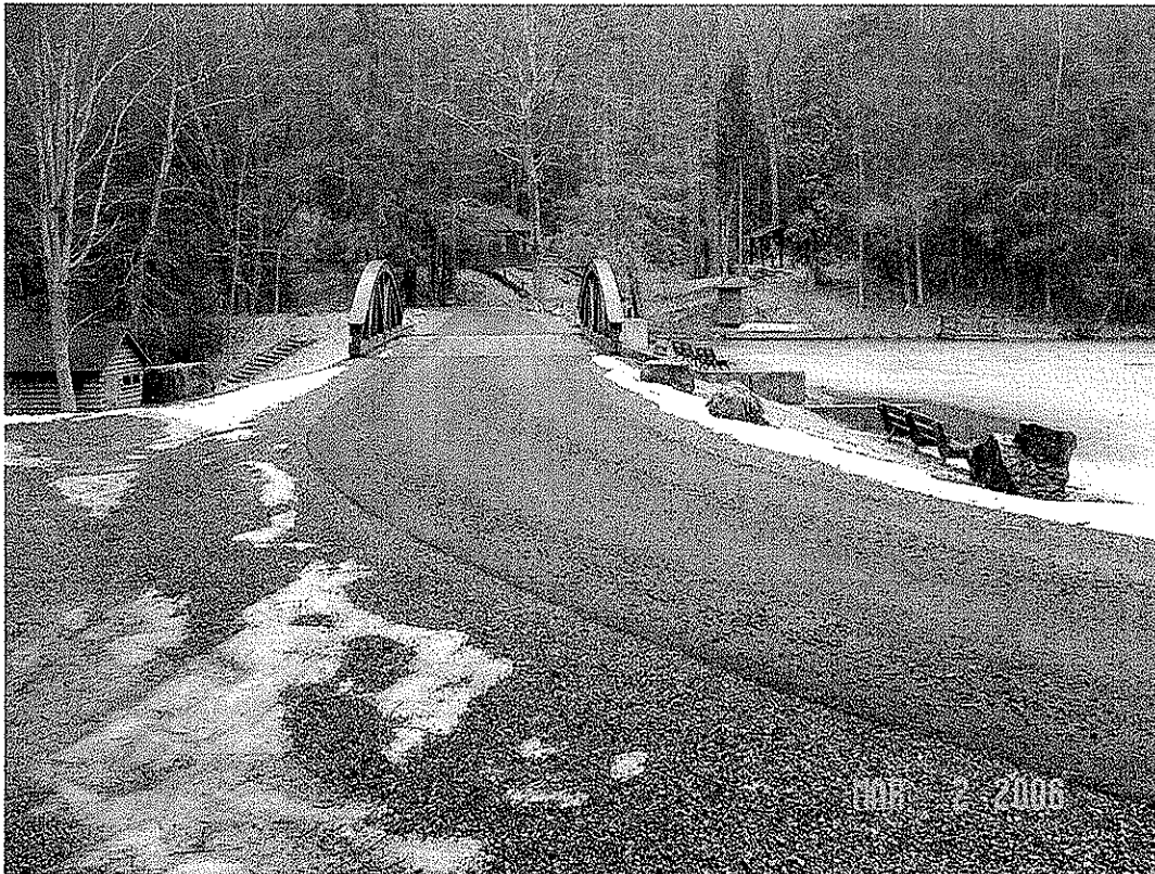
SENECA DAM MODIFICATION, POCAHONTAS CO., WV
