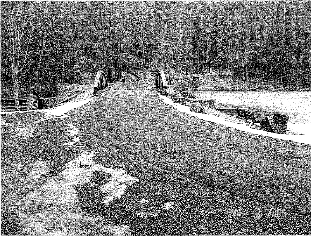
SENECA DAM MODIFICATION, POCAHONTAS CO., WV
