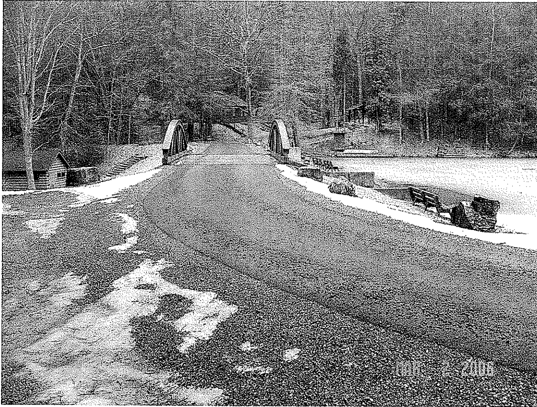
SENECA DAM MODIFICATION, POCAHONTAS CO., WV
